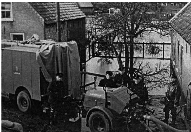
Langedijk: Fordson WOT-2 met kenteken GZ-83235 met Dennis motorspuitaanhangser van de post Noord-Scharwoude. Bijzonder is de opbouw als 'bellenwagen'.
